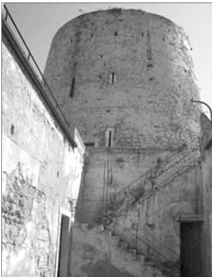
La torre degli inglesi
